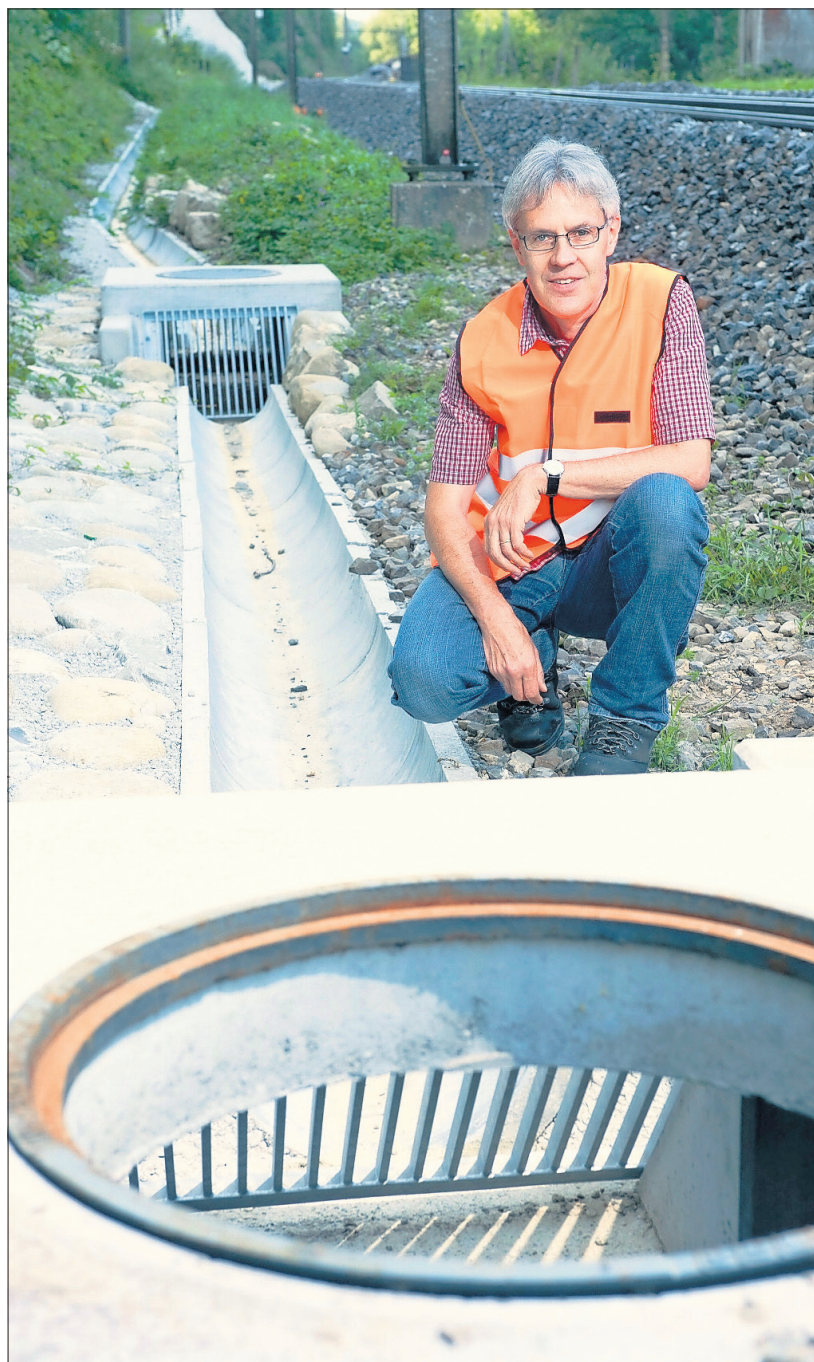
Peter Meier, Umweltbeauftragter der SBB, vor einem der neuen Wasserschächte. Diese verfügen über Ausstiegshilfen für Kleintiere.
