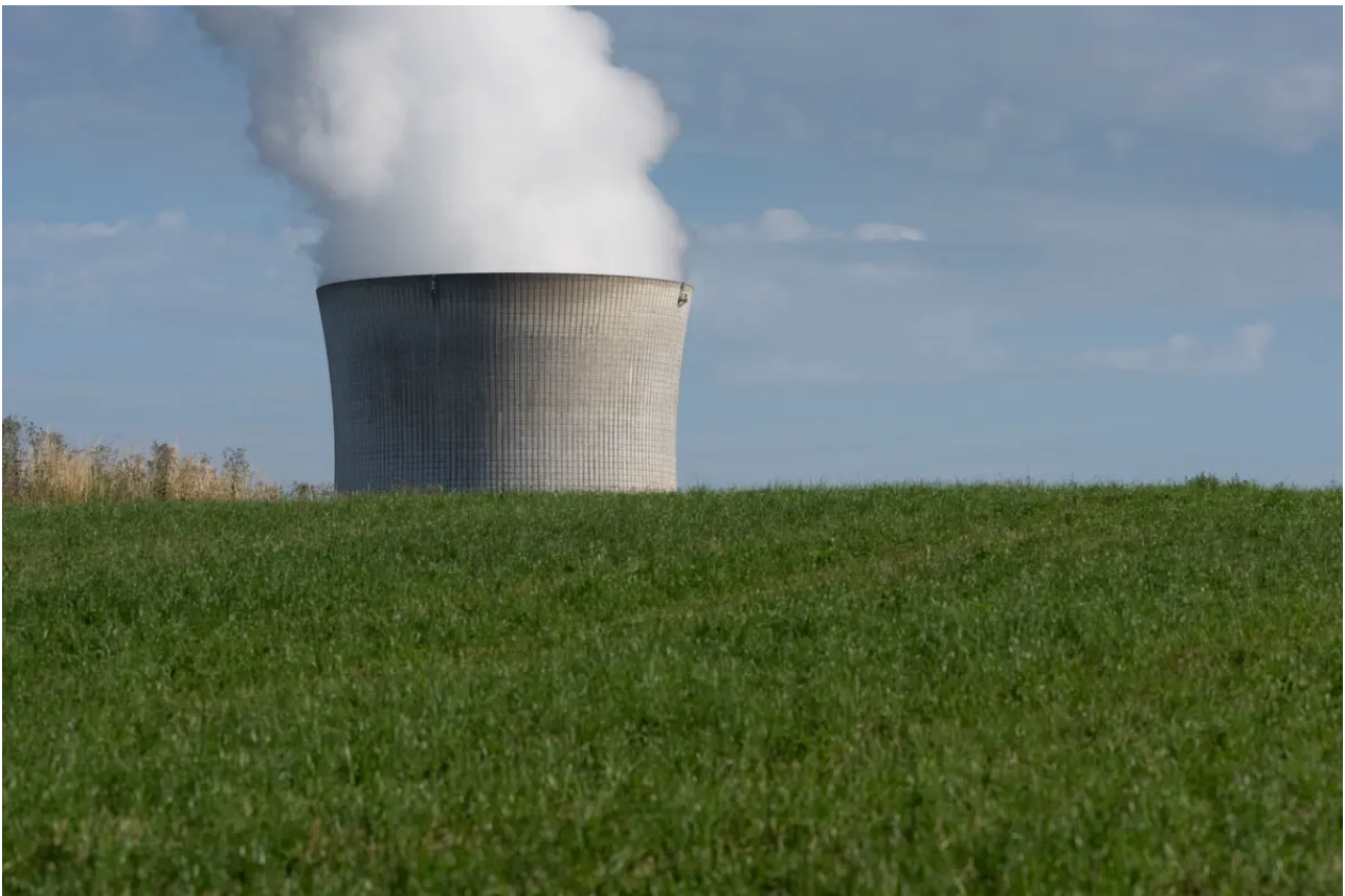
Dampf aus dem Kühlturm des Kernkraftwerks Leibstadt.
